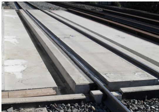
Bild 14: Beispiel Brücke mit fester Fahrbahn (nach Schall 03, Tab. 9, Zeile 4)
