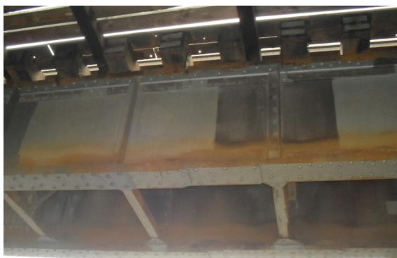
Bild 11: Beispiel Brücke mit stählernem Überbau, Gleise direkt aufgelagert (nach Schall 03, Tab. 9, Zeile 1)
