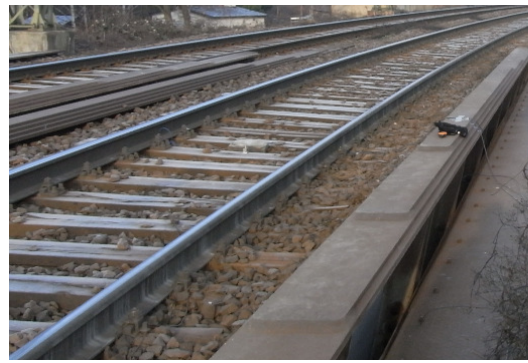
Bild 12: Beispiel Brücke mit stählernem Überbau und Schwellengleis im Schotterbett (nach Schall 03, Tab. 9, Zeile 2)
