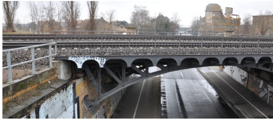
Bild 12: Beispiel Brücke mit stählernem Überbau und Schwellengleis im Schotterbett (nach Schall 03, Tab. 9, Zeile 2)
